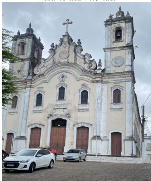
Figura 4 - Fachada principal da Catedral de Nossa Senhora do Rosário das Vitórias.
