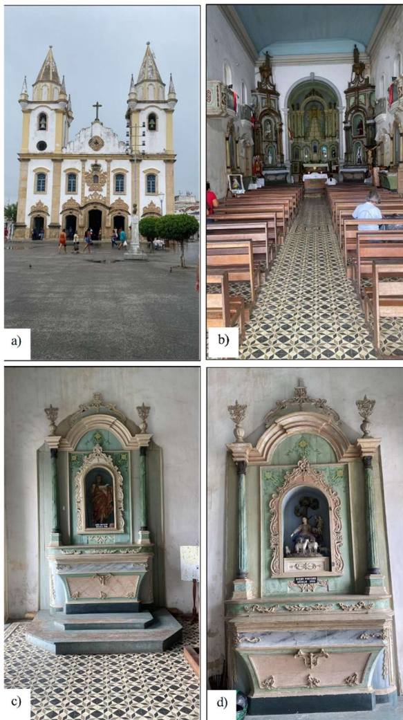
Figura 3 - Conjunto de fotos Igreja São Gonçalo de Garcia dos Homens Pardos.
